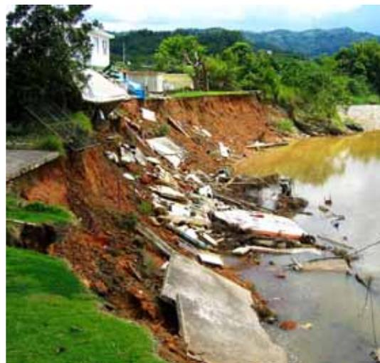
Ilustración 1.1: Daños causados a viviendas por migración de meandro en Río Turabo, Caguas.
