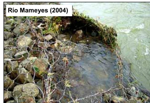
Ilustración 9.11: Ruptura de las cajas de gaviones (segunda etapa de falla por fuerza hidráulica).
