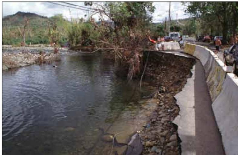
Ilustración 10.12: Erosión de talud en Río Mameyes luego del Huracán Georges, septiembre 1998.
