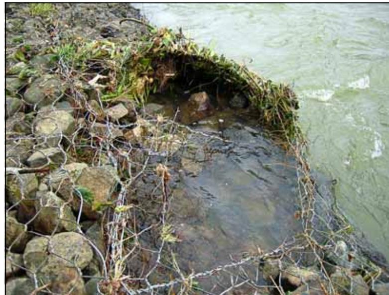
Ilustración 10.15: Falla de gaviones por fuerza hidráulica (2004).
