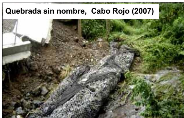
Ilustración 9.8: Falla de gaviones nuevos en "caja" por socavación hidráulica.
