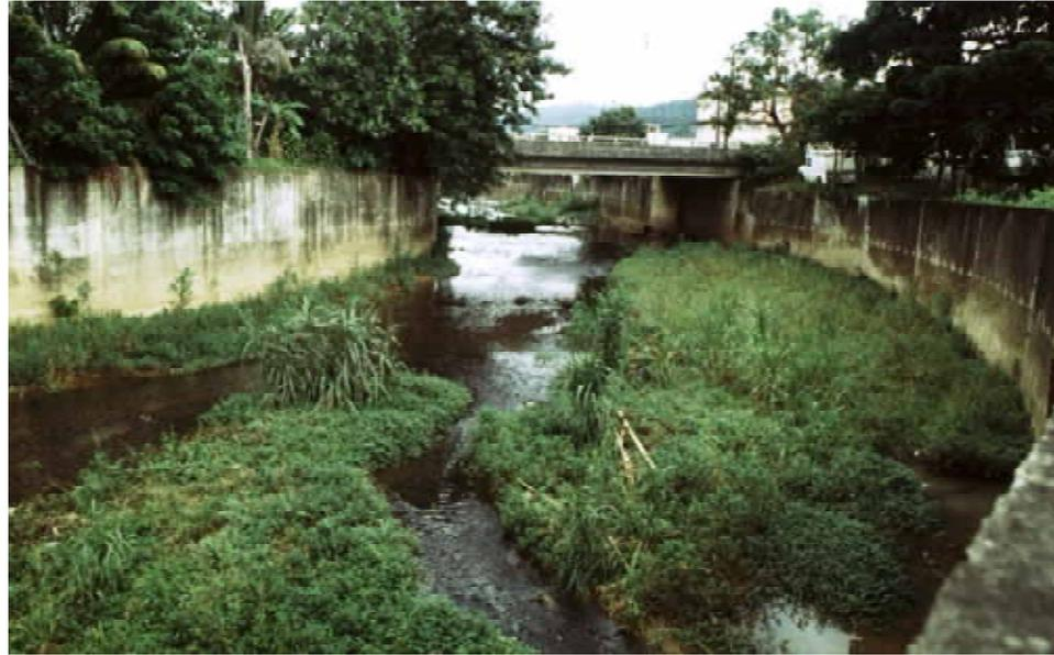
Ilustración 3.18: Canalización inestable debido a la acumulación de sedimentos, Río Yagüez, Mayagüez.
