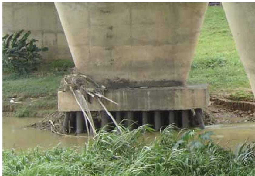
Ilustración 3.4: Pilas-tras expuestas del puente de la PR-22 en Bayamón.
