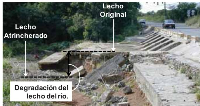
Ilustración 3.6: Puente vado de la carretera PR-3 en Salinas, mostrando proceso de atrincheramiento aguas abajo.
