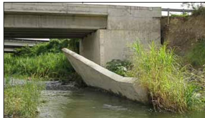
Ilustración 10.8: Colapso de estribo por atrincheramiento del lecho (2008).
