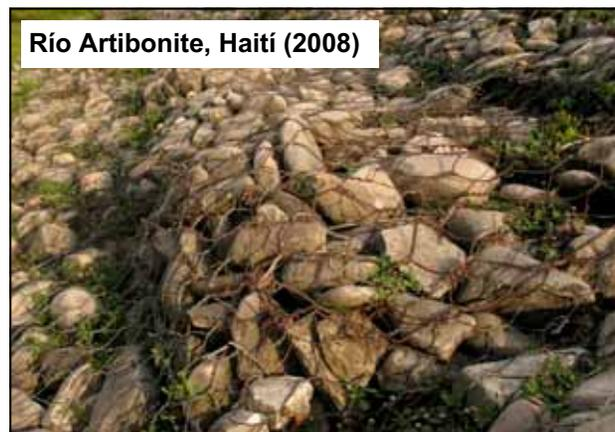
Ilustración 9.10: Deformación de las cajas de gaviones (primera etapa de falla por fuerza hidráulica).
