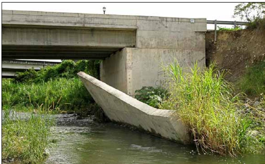
Ilustración 9.3: Colapso de estribo de puente por atrincheramiento de Río Inabón.
