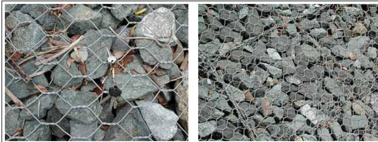
Ilustración 9.5: Gaviones recién instalados.
