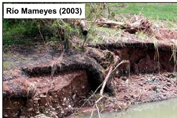
Ilustración 9.9: Falla de gaviones nuevos en "colchón" por socavación hidráulica.
