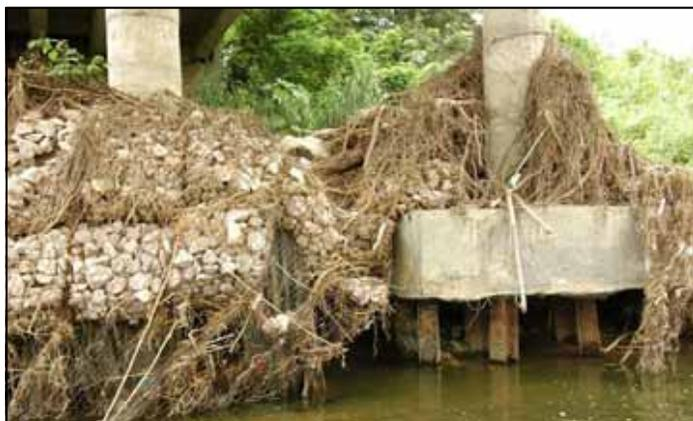
Ilustración 10.6: Falla de gaviones y pilastras expuestas del puente de la PR-52 en Río Inabón.
