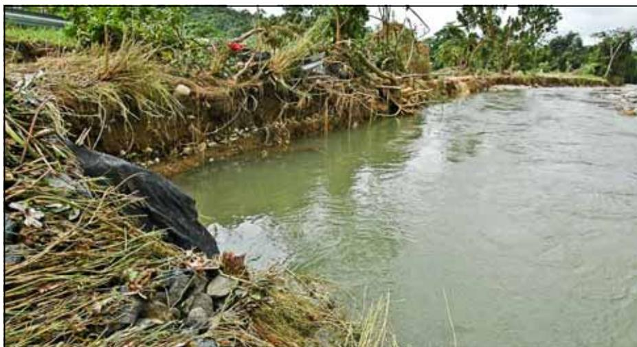
Ilustración 10.14: Límite aguas debajo de la instalación de los gaviones, señalando la erosión adicional (2004).
