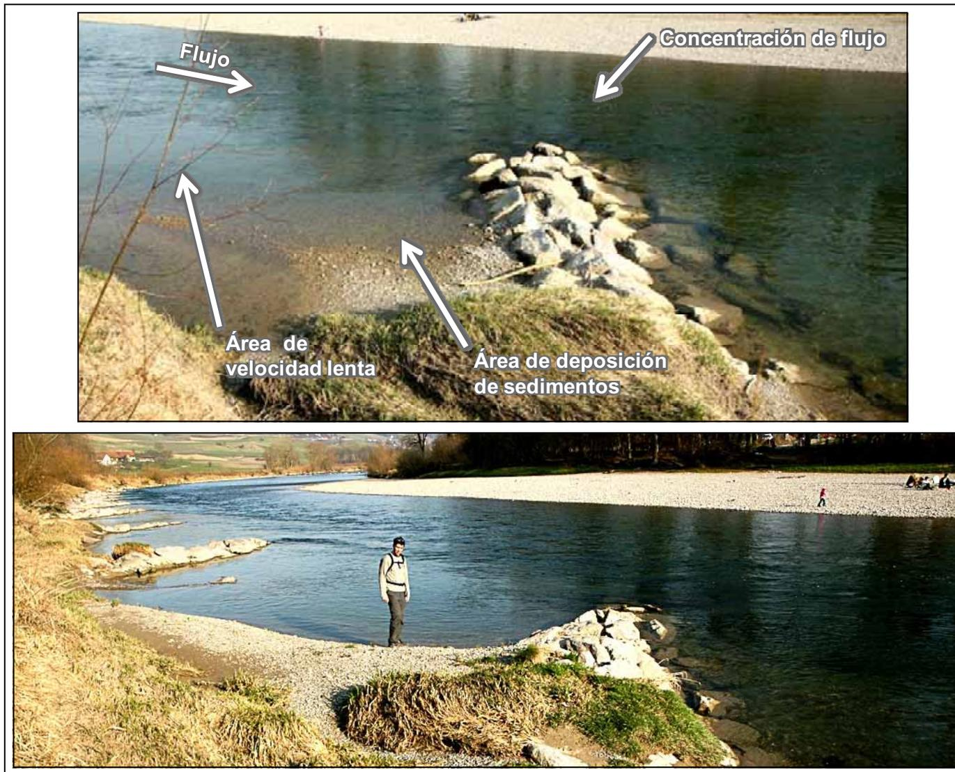
Ilustración 9.14: Guías de roca instalados en Suiza.
