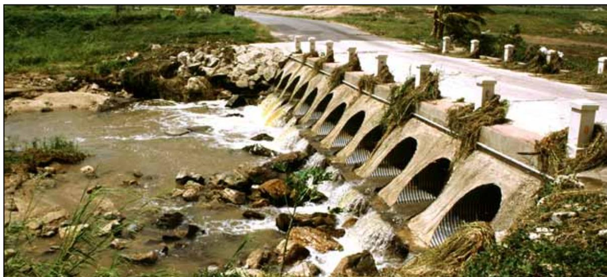
Ilustración 9.23: Puente vado en Humacao. La notable socavación de la cara aguas abajo demuestra que esta es la zona de mayor riesgo de falla estructural.
