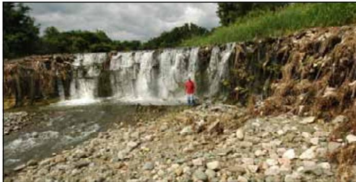
Ilustración 10.5: Salto de agua producido por la falla de gaviones.
